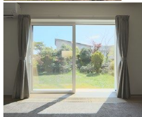
外窓交換（はつり工法）を実施
