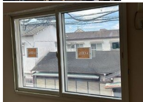
主居室の南側に内窓設置
