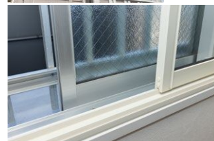
全住戸の内窓設置を実施
