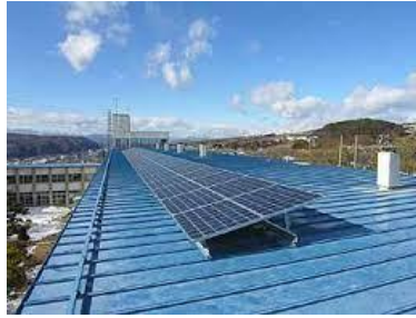
学校の屋上への太陽光発電設備の設置例（出典：文部科学省ホームページ）
