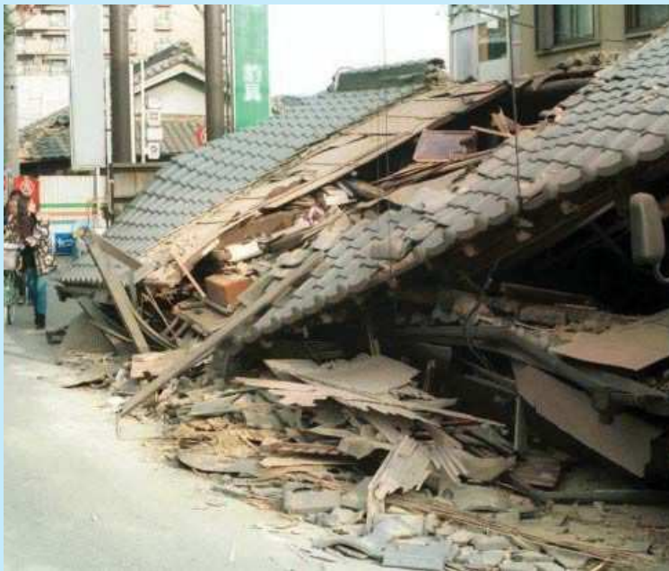
1995年兵庫県南部地震（阪神・淡路大震災）による家屋の倒壊（吉嶺充俊教授（東京都立大学工学部土木工学科）撮影）
