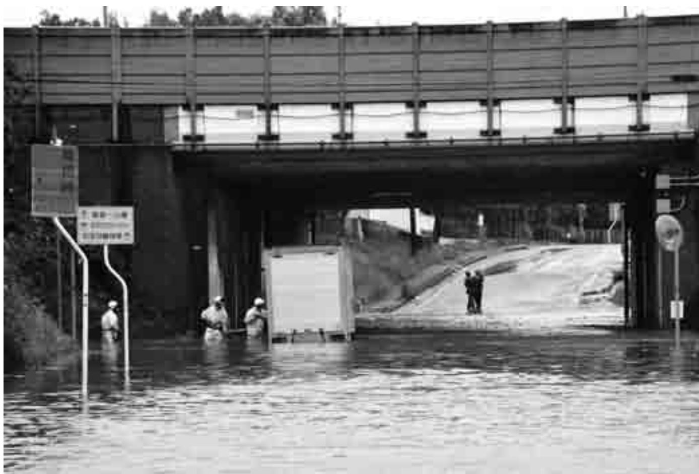
▲冠水した道路で身動きが取れなくなったトラック（8月22日(月)、月輪地内）
