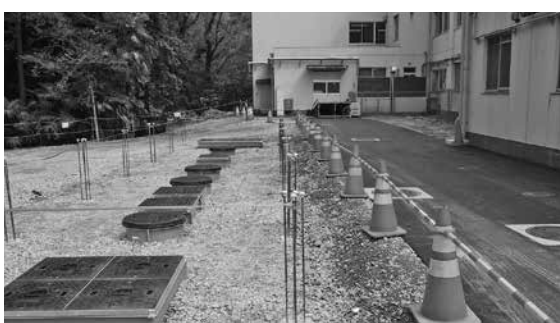
入れ替えた新設浄化槽
