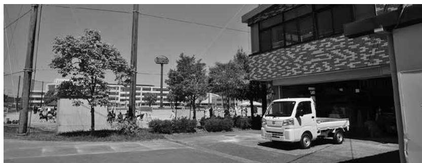
管理棟と西側道路入口
