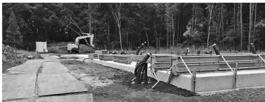
羽尾地区区内で進む「系統用蓄電池」の設置工事
