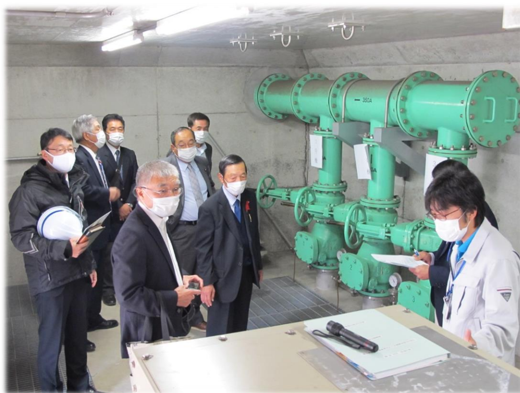
月の輪地区西通線排水ポンプ自家発電設備修繕事業現場視察
