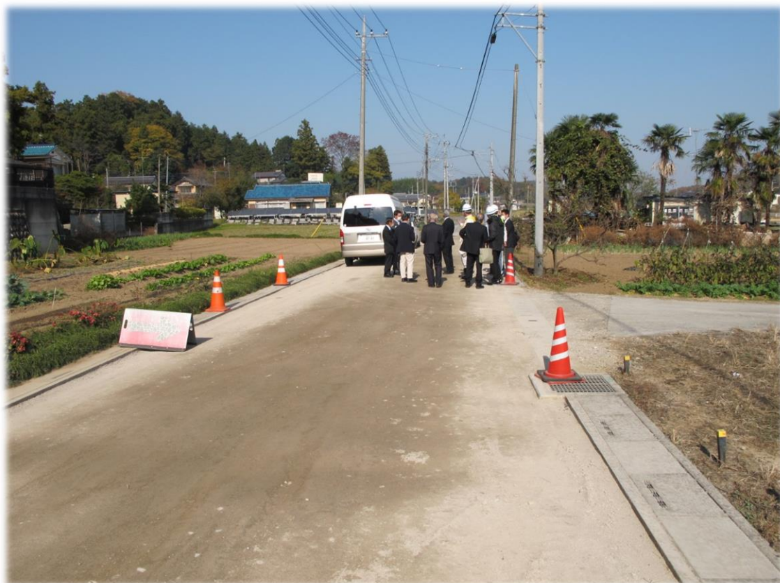
和泉地区の道路改良工事現場
