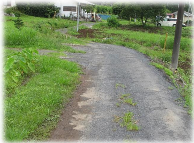
用地確保済みで工事未着手現場。
