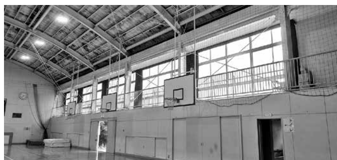
宮前小学校 体育館
