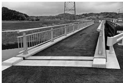
完成した大木橋側道橋
