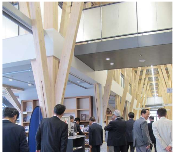
地元産の木材を用いて建てられた役場庁舎
