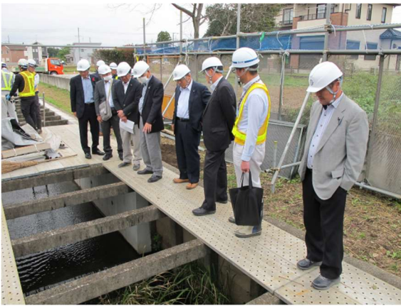
流末排水路修繕等工事
