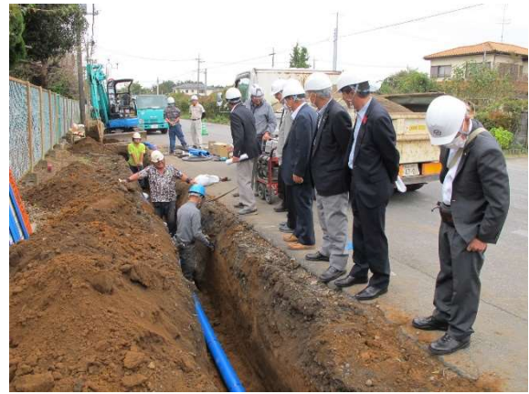
配水管布設替工事
