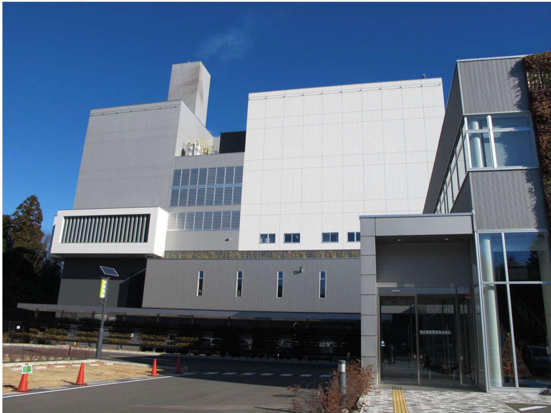
埼玉西部クリーンセンター（鳩山町内）
