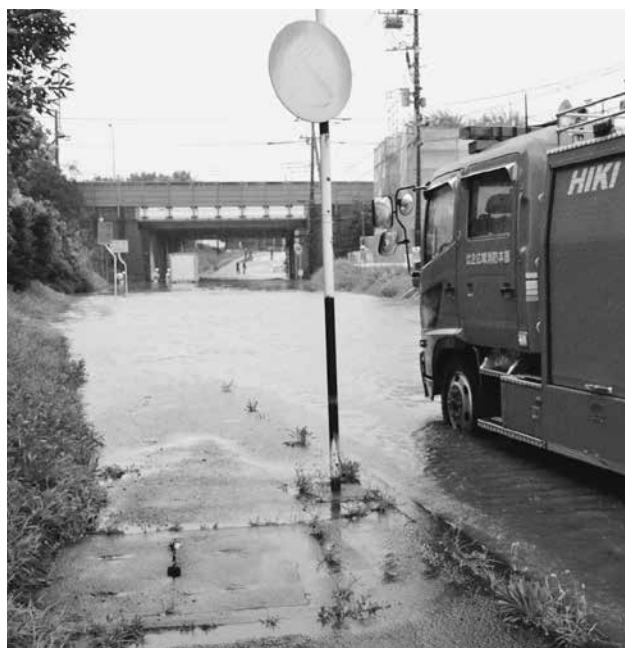
冠水した町道(月輪)
