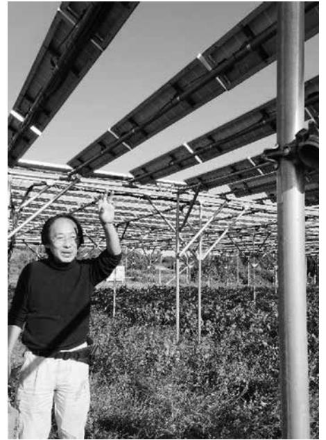
千葉県匝瑳市のソーラーシェアリングシステム 太陽光パネルとその下で作物を栽培している
