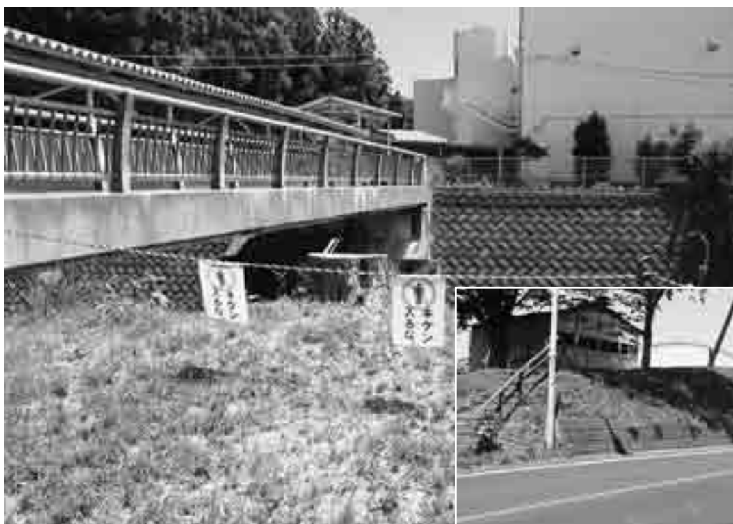
安全対策が望まれる南側駐車場
