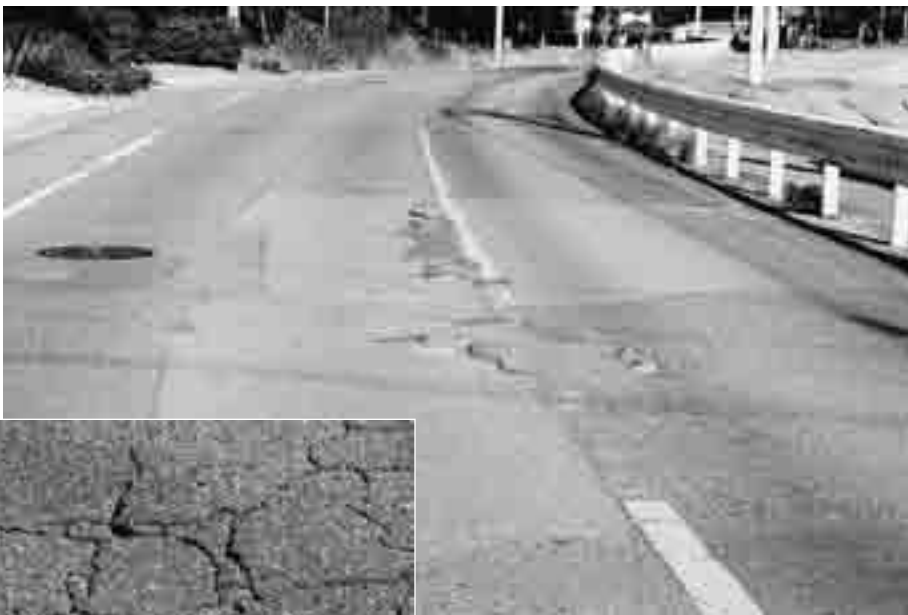
▲常温合剤での補修
