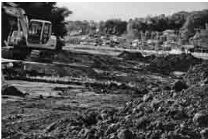
羽尾中部のほ場整備
