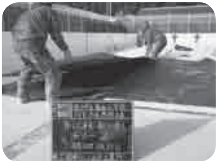
漏水により床パネル取外し修理
