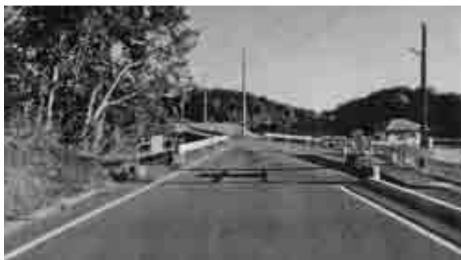
103号線道路改良工事着工前 終点
