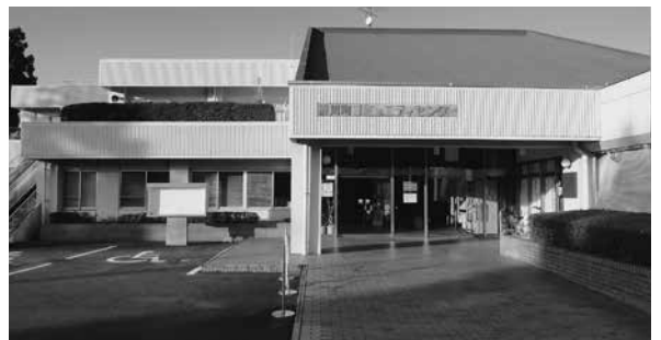
老朽化し建替えの検討が必要なコミュニティセンター
