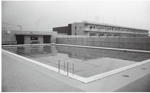
月の輪小学校プール
