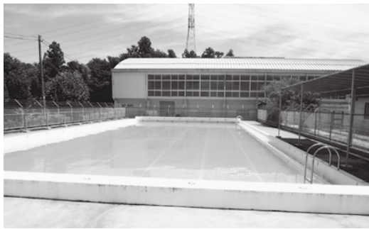
宮前小学校プール
