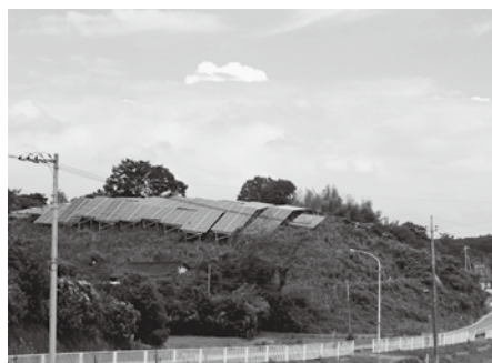
山林に設置された太陽光発電パネル
