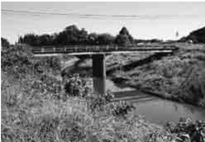
耐震設計以前の橋
