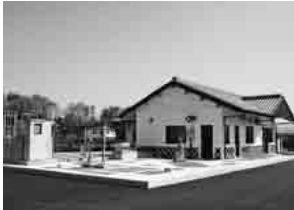
野原・土塩地区農業集落排水施設
