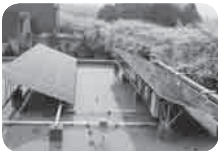
庁舎屋上の太陽光発電パネル
