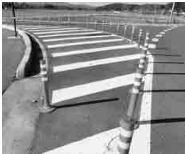
広くとりすぎた巻き込み事故防止対策
