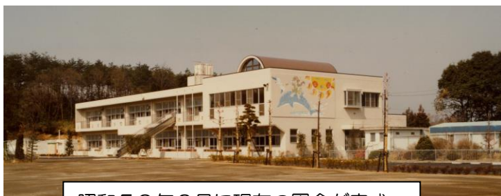
昭和59年2月に現在の園舎が完成
