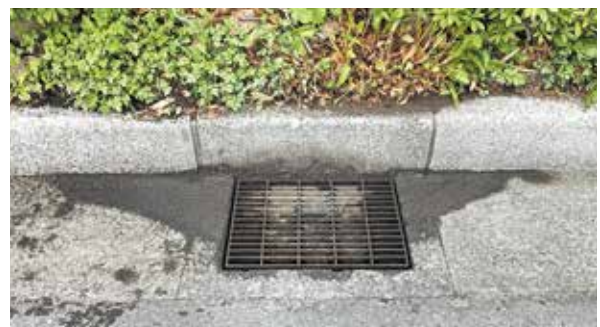
【グレーチング清掃後】
